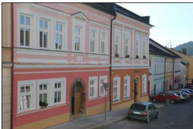
Oprava fasády, oken a střechy domu č. 49 a 50.
