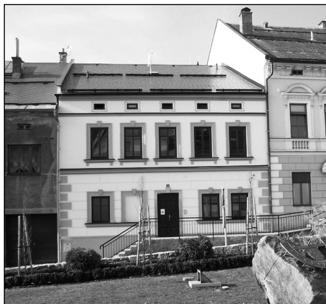
Dům č. 12 před a po rekonstrukci
