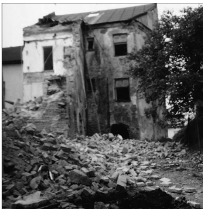
Demolice zadního traktu domu č. 48 roku 1999
