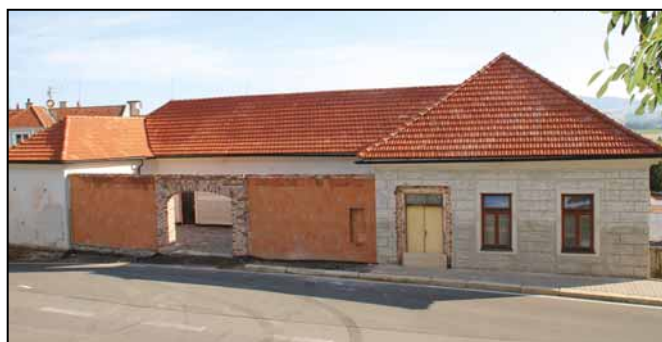
Pokračující rekonstrukce bývalé basy.
