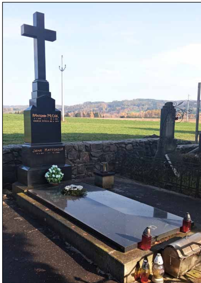
Probíhající oprava hřbitovní zdi.
