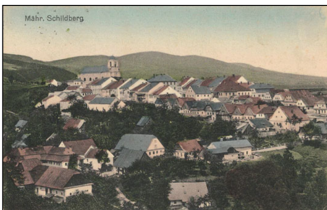
Pohled na část dnešní ulice Školní s historickou částí v pozadí. Kolorovaná pohlednice Šilperka od jihovýchodu na počátku 20. století. Vydal Kroboth & Brix.
